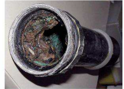
Exemple de biofilm dans une canalisation
